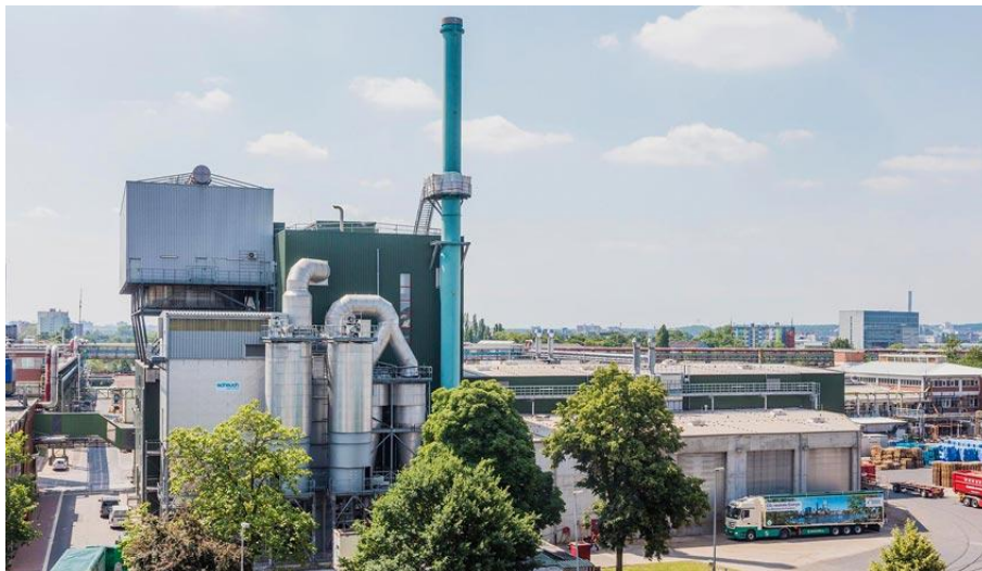
Abbildung 105. Biomassekraftwerk in Biomassekraftwerk in Frankfurt-Fechenheim
