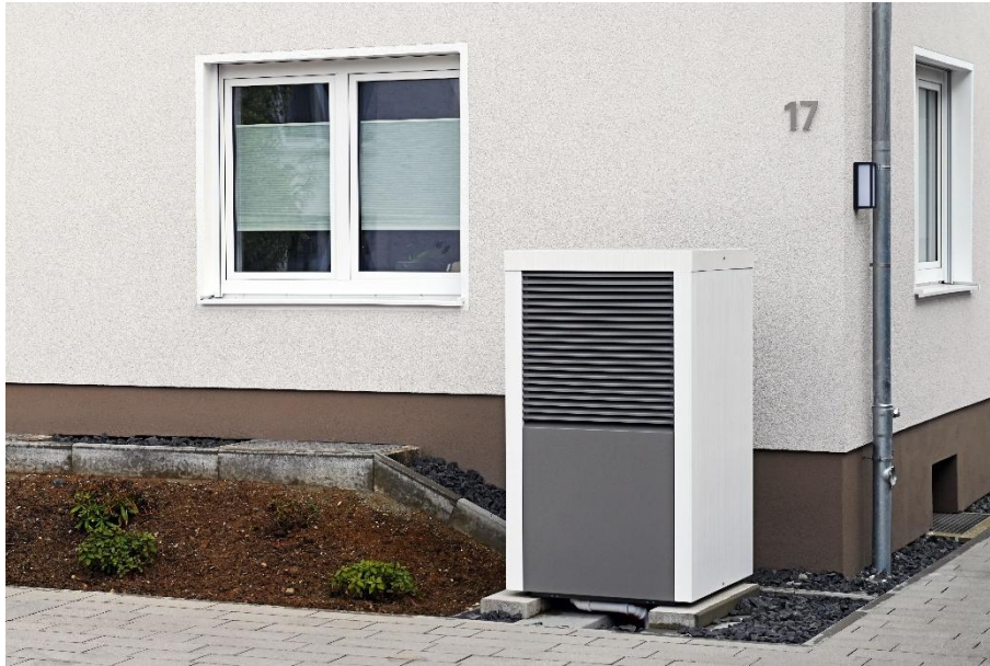
Abbildung 100. Luft-Wasser-Wärmepumpe als dezentrale Lösung in Gebieten ohne Fernwärme
