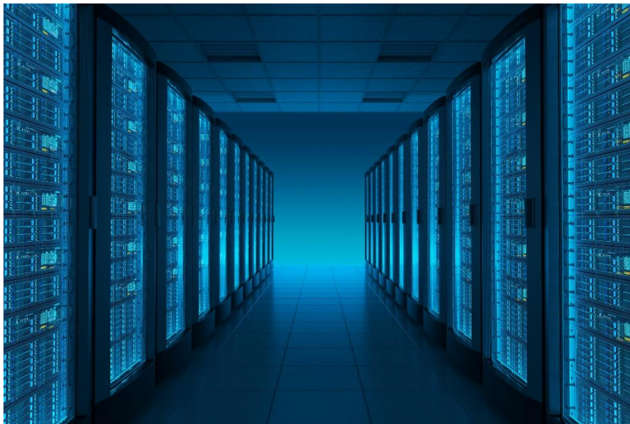
Abbildung 101. Rechenzentrum mit Serverracks
